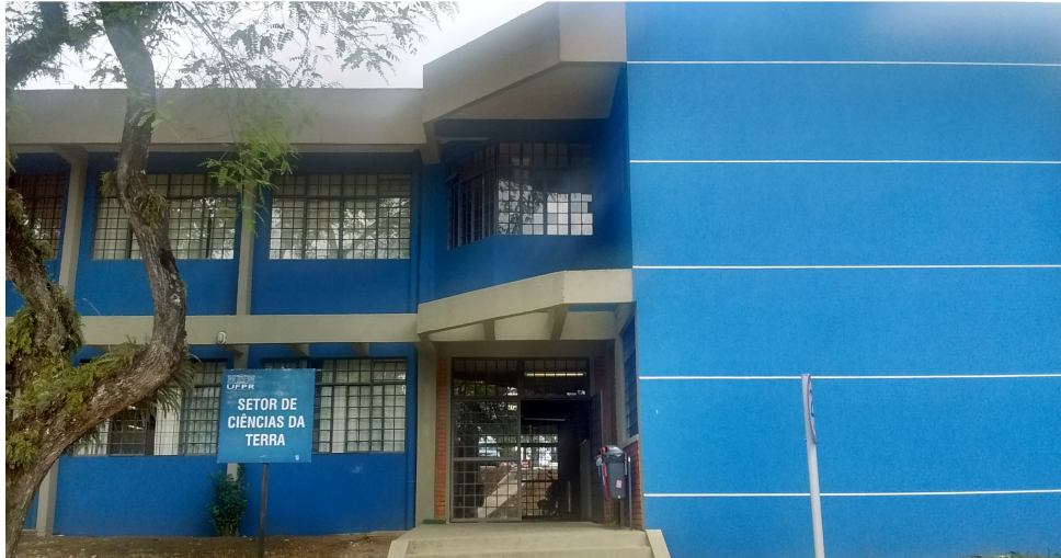
Figura 4.11: Prédio das CT's(Fonte: Autor).
