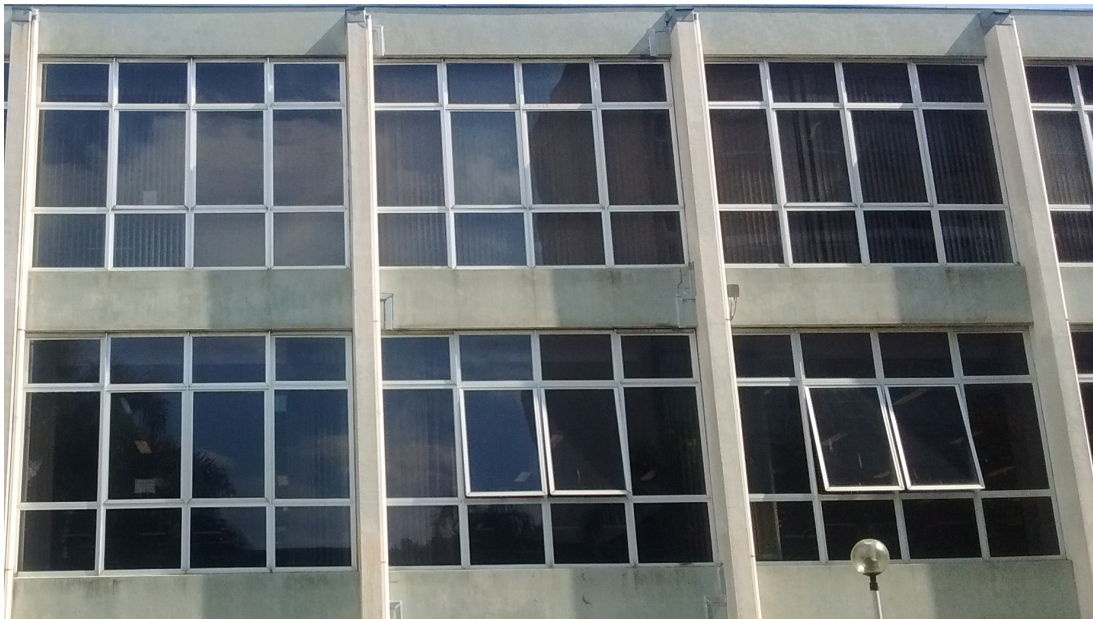
Figura 4.4: Prédio da Biblioteca(Fonte: Autor).
