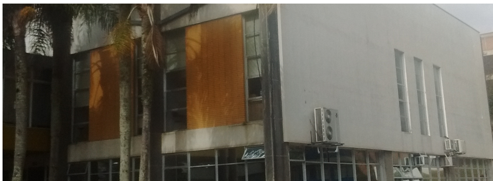
Figura 4.12: Prédio Departamento de Informática(Fonte: Autor).
