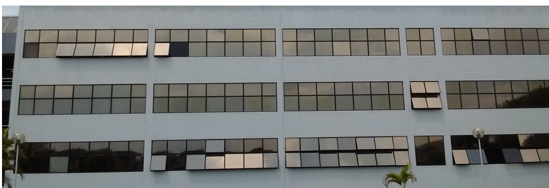
Figura 4.15: Prédio de Sociais Aplicadas(Fonte: Autor).
