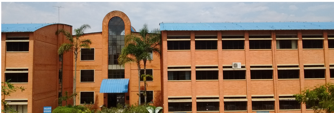
Figura 4.13: Prédio de Engenharia Industrial Madeireira(Fonte: Autor).
