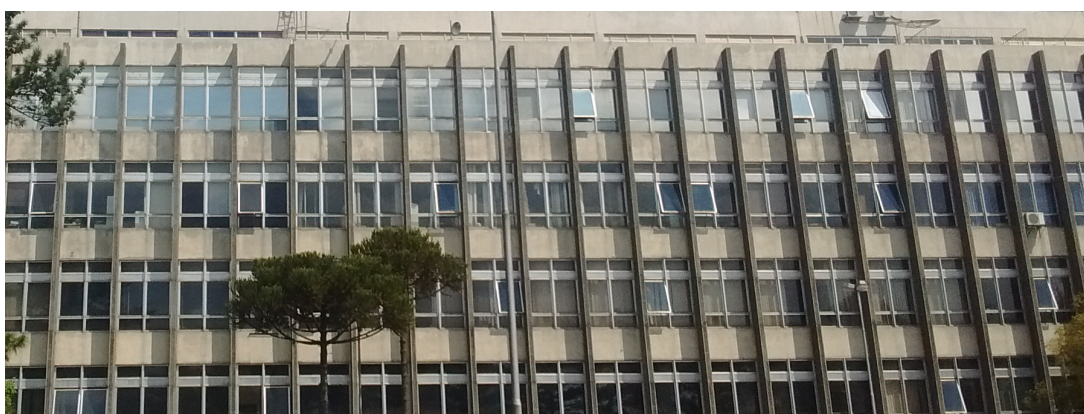
Figura 4.3: Prédio da Administração(Fonte: Autor).
